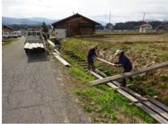
○春の水路の蓋外し作業
